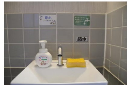
自動水栓 取り付け
