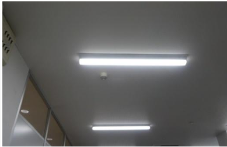
全棟蛍光灯からLEDに
