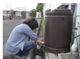
雨水を有効活用して 花壇に散水
