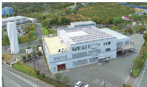
新都田工場 発電設備出力49.5kW 面積1,000㎡
