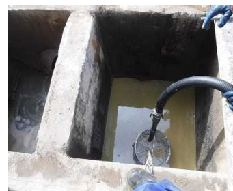
油水分離槽の清掃作業
