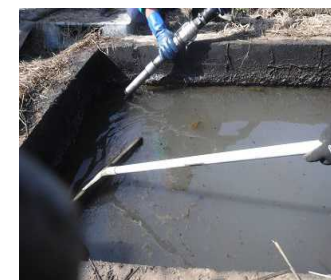
油水分離槽の清掃作業
